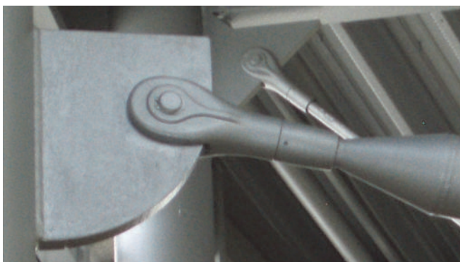
Verbindung Druckstabsystem an Anschlussblech
